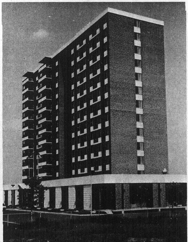
LE MANOIR DE VERDUN. Le Manoir de Verdun est un foyer pour personnes âgées inauguré en octobre 1970. Ce foyer a été construit grâce à un prêt de $2,685,100 consenti par la Société d'habitation du Québec. Le Manoir de Verdun a une hauteur de 13 étages et contient 320 lits. Ce foyer est administré par une corporation sans but lucratif.
