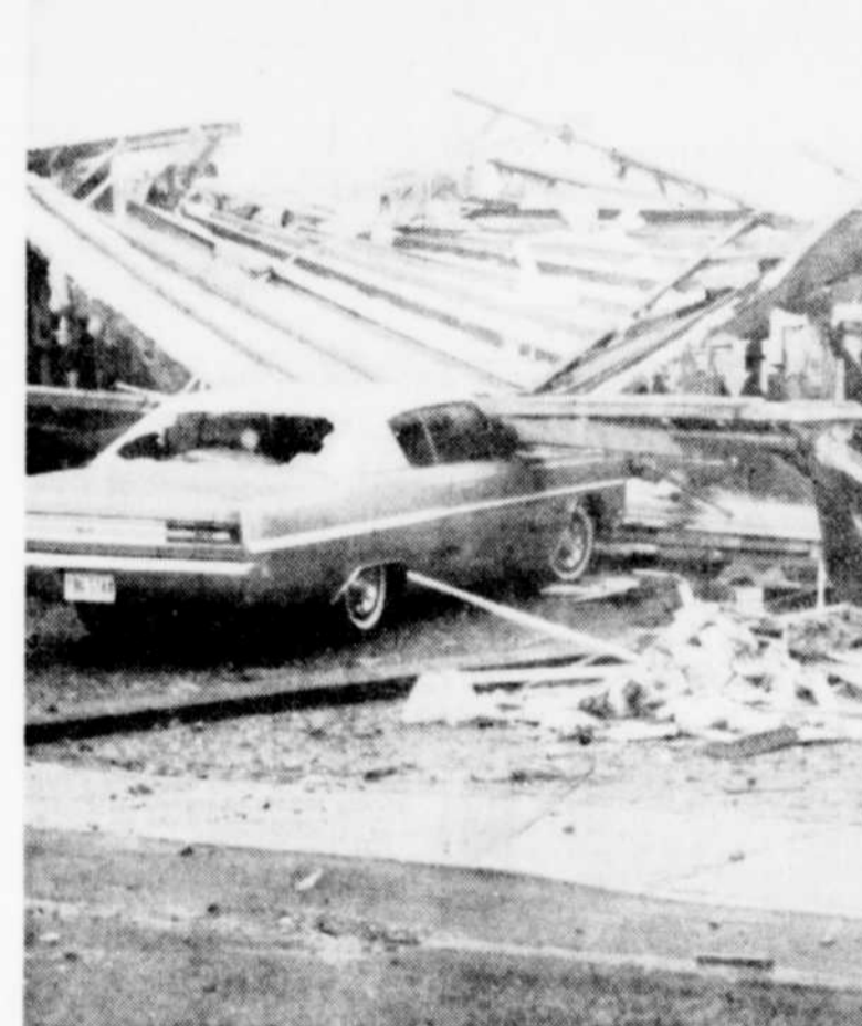
UN ORAGE PAR JOUR... c'est devenu presque une routine au cours de cet été particulièrement humide... mais parfois l'orage se fait tempête et cause de lourds dommages, comme hier, à East Broughton, où, entre autres, il a soulevé la toiture d'une quincaillerie de l'Avenue du Collège et l'a projetée à environ 400 pieds de là. La bâtisse, ensuite, s'est écroulée, comme le montre cette photo. A Granby la foudre a creusé un trou de six pieds de diamètre dans un édifice commercial de la rue Dufferin; à Drummondville, des rues ont été inondées... Et l'été n'est pas encore fini... (Photo Le Tribune, Theford Mines)
