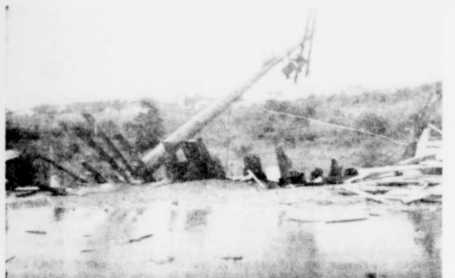
POTEAU SECTIONNÉ — Un poteau de téléphone a été sectionné en deux lors du passage de la foudre et du vent.
