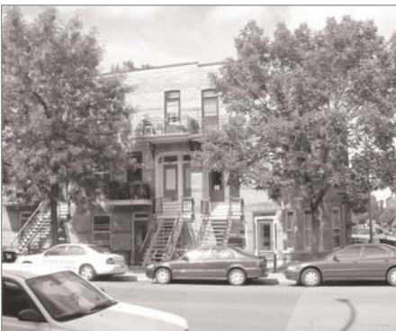
201-249, rue Villeneuve Ouest Ensemble résidentiel
