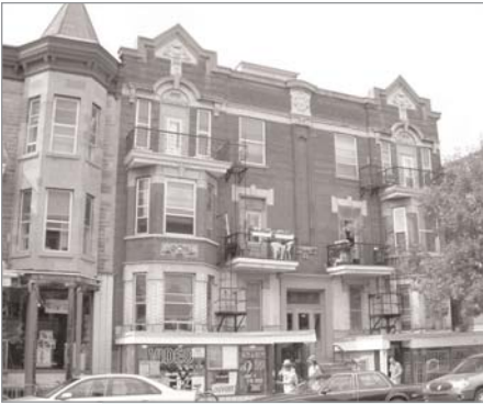
115-119, avenue du Mont-Royal Ouest Appartements Carrière
