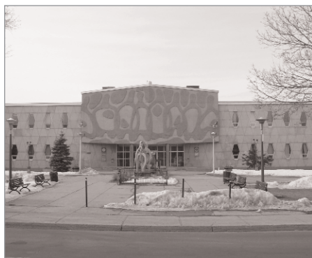
2275, boulevard Saint-Joseph Est Centre du Plateau
