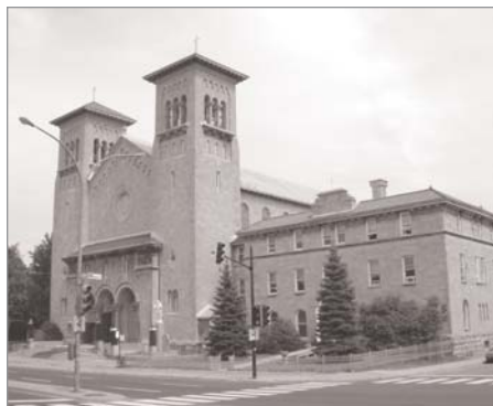
2000, boulevard Saint-Joseph Est et 4850, avenue De Lorimier Église et presbytère Saint-Pierre-Claver
