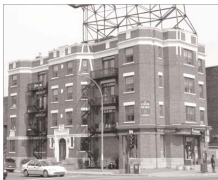
294, rue Villeneuve Ouest et 4685, avenue du Parc Appartements Pierrefonds
