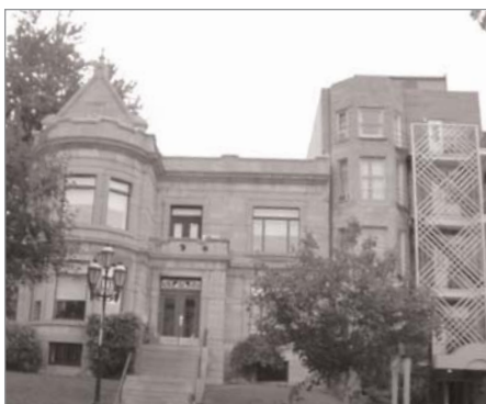
839, rue Sherbrooke Est Maison Isaïe-Préfontaine
