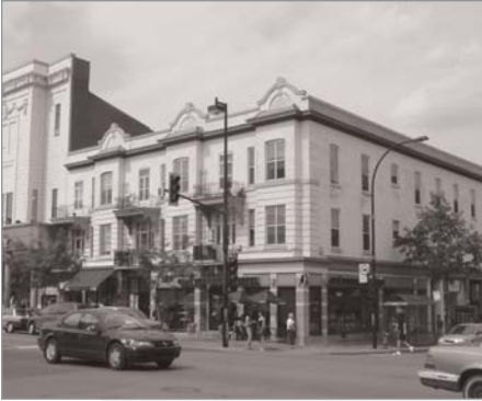
5101-5111, avenue du Parc Ensemble résidentiel
