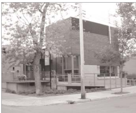
955, rue Marie-Anne Est et 4356-4358, rue Boyer Piscine Lévesque
