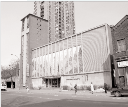
3535, avenue du Parc Sanctuaire Notre-Dame- de-la-Salette
