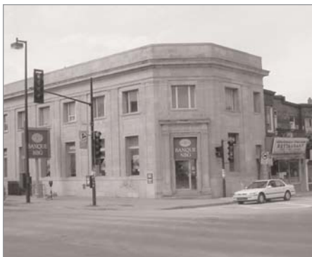
5801-5811, avenue du Parc Ancienne Banque Royale
