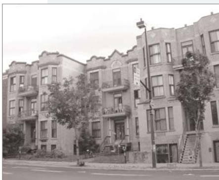
5944-5956, avenue du Parc Appartements Belnord
