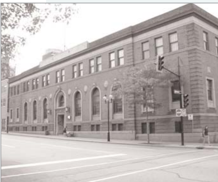
265, avenue du Mont-Royal Ouest Mortimer Davis Building
