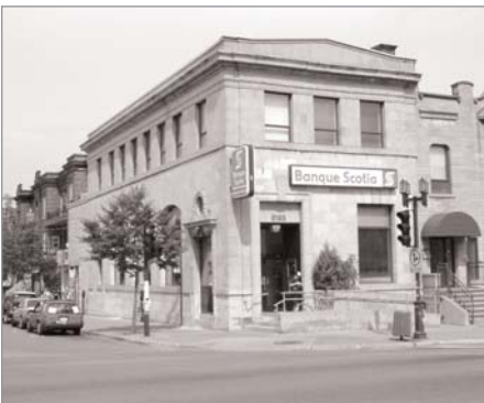
5185, avenue du Parc Ancienne Bank of Ottawa
