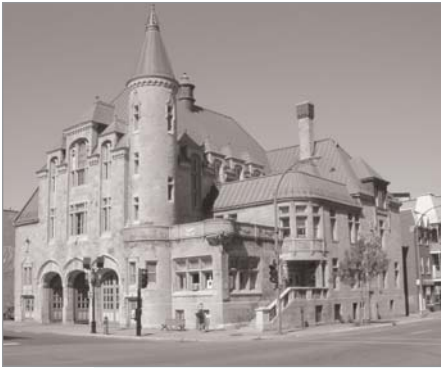
1-5, avenue Laurier Ouest Ancien hôtel de ville de Saint-Louis-du-Mile End
