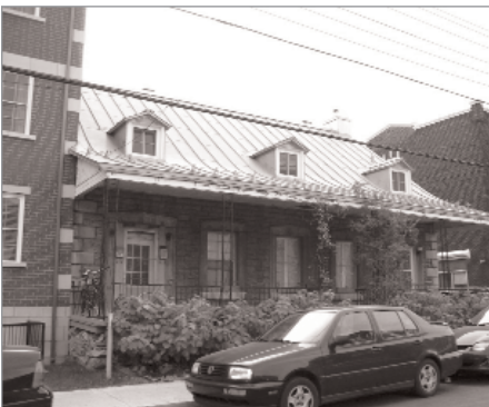
5208-5210, rue Berri Maison de faubourg
