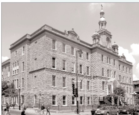
465, avenue du Mont-Royal Est Ancien pensionnat Saint-Basile
