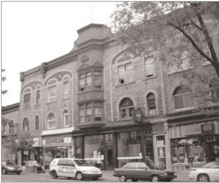
3628-3658, boulevard Saint-Laurent Édifice Préfontaine
