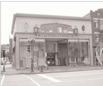
4800, avenue du Parc Édifice Lalonde
