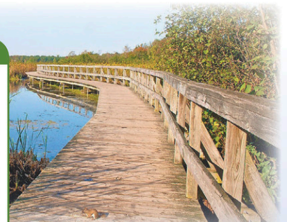
Passerelle au CINLB.
