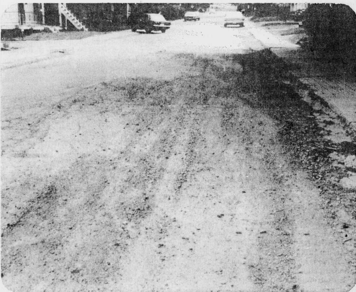
Les résidents de la rue Montplaisant ne demandent que quelques pelletées de gravier pour boucher les trous et un épandage providentiel de sel pour éliminer la poussière en attendant les équipes du département de la voie publique. (Photo La Tribune, Royal Roy)
