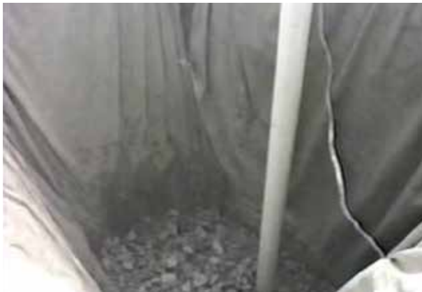
30 juillet 1991 – Phase de remblayage
