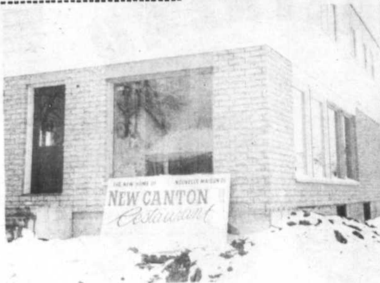
Sur cette photo, on voit le futur site du restaurant NEW CANTON, au numéro 278, du boulevard St-René Coupil. Le propriétaire de cet établissement désire annoncer à toute la population de Gatineau que son restaurant sera aménagé dans ce nouvel édifice avec un équipement entièrement neuf. La cuisine sera spécialement aménagée également avec un équipement des plus modernes. Surveillez la date d'ouverture du NEW CANTON RESTAURANT à ce nouvel endroit. (Photo Roland Lafrance)
