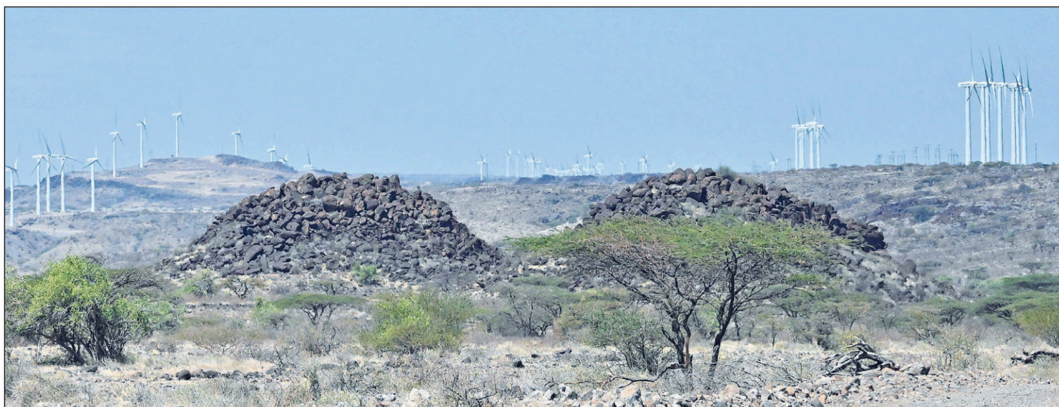
Près du lac Turkana, le parc éolien est composé de 365 éoliennes qui sont alimentées par les vents qui arrivent de l'océan Indien situé à plus de 1000 kilomètres. Le plus important parc du genre en Afrique.
