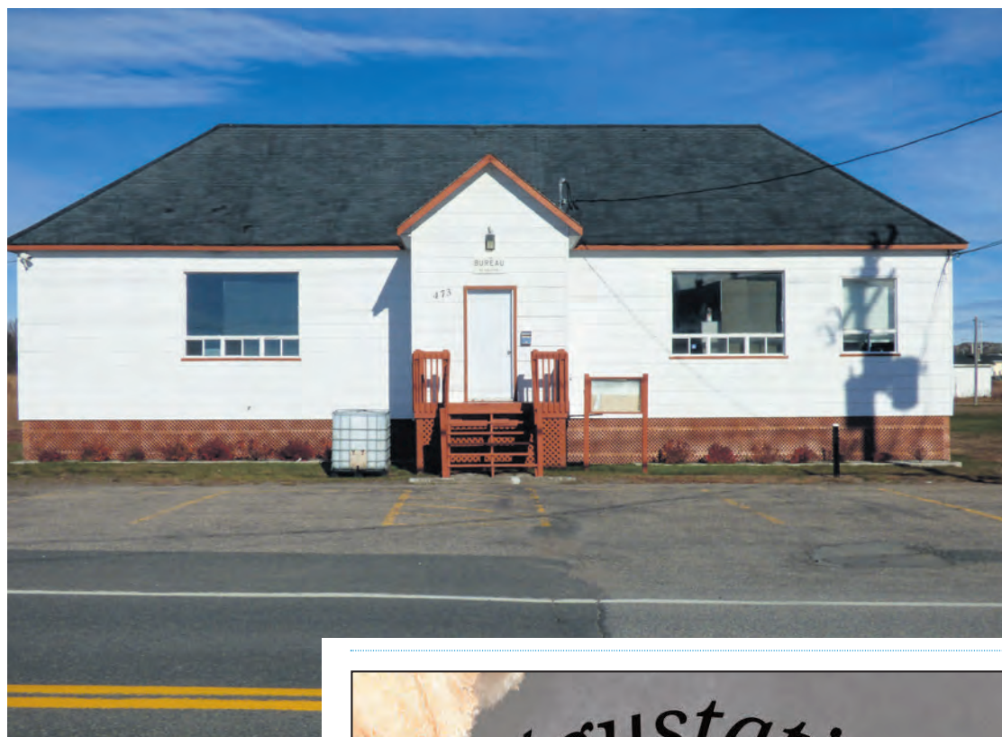
Le bâtiment municipal de Rivière-au-Tonnerre est désuet.
