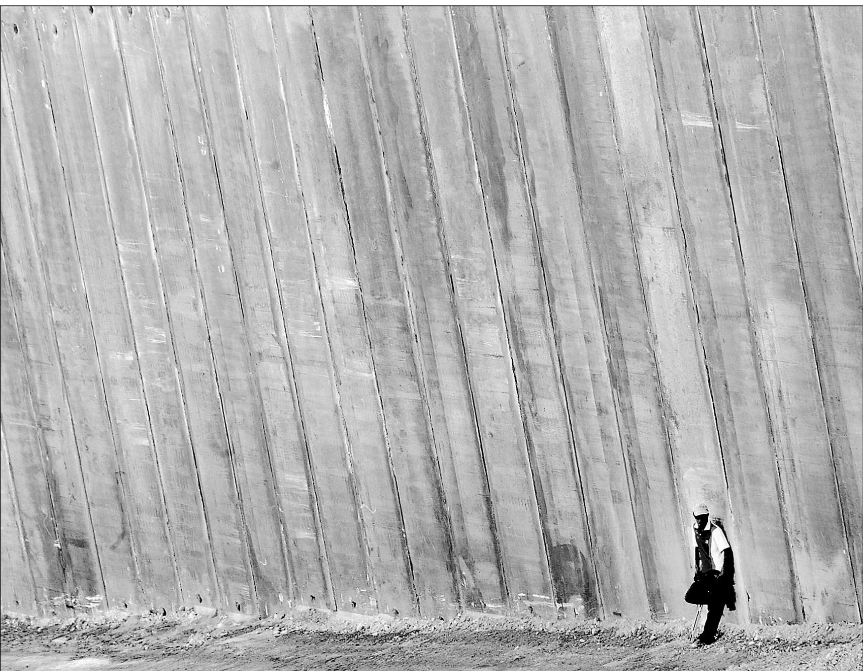
Cet ouvrier palestinien se repose un moment, appuyé sur le mur de huit mètres qu'érige Israël, près de Jérusalem-Est notamment, en guise de protection contre des attentats pouvant venir de Cisjordanie.
