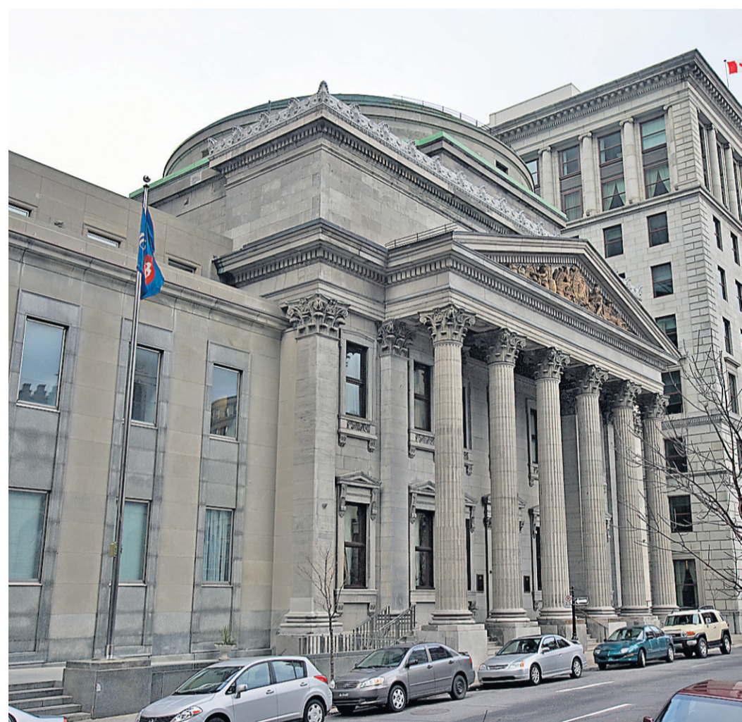
L'immeuble de la Banque de Montréal subit une double influence: la Commercial Bank d'Écosse à Édimbourg et le Panthéon de Rome.
