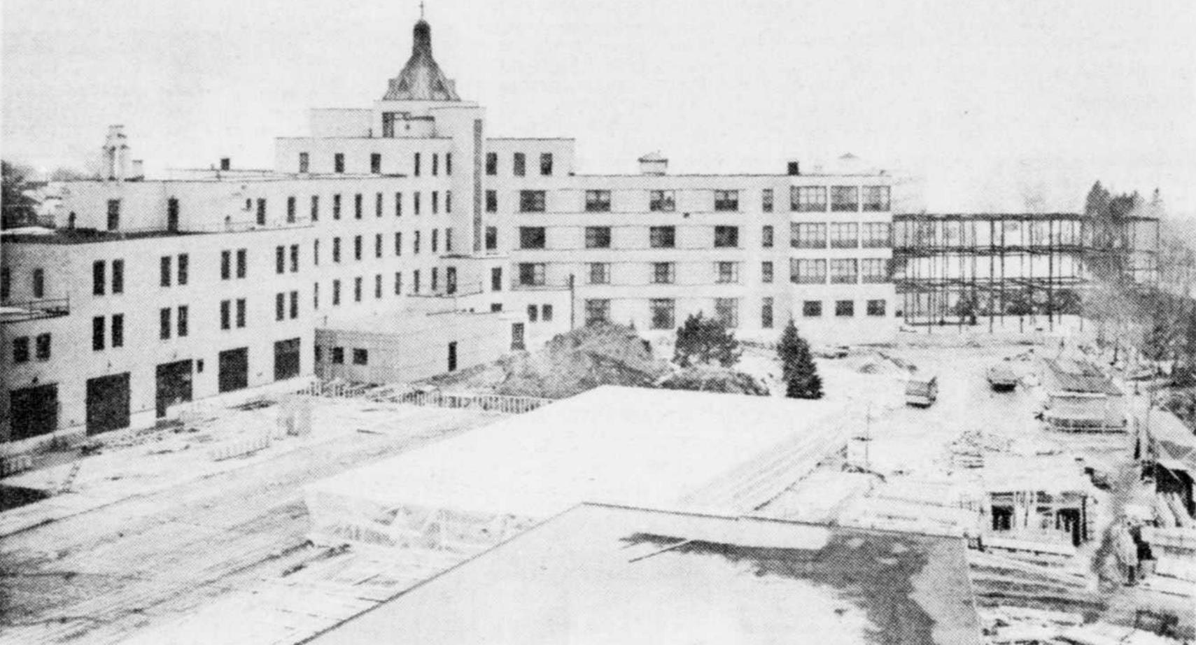
Travaux d'agrandissement à l'hôpital Hôtel-Dieu
