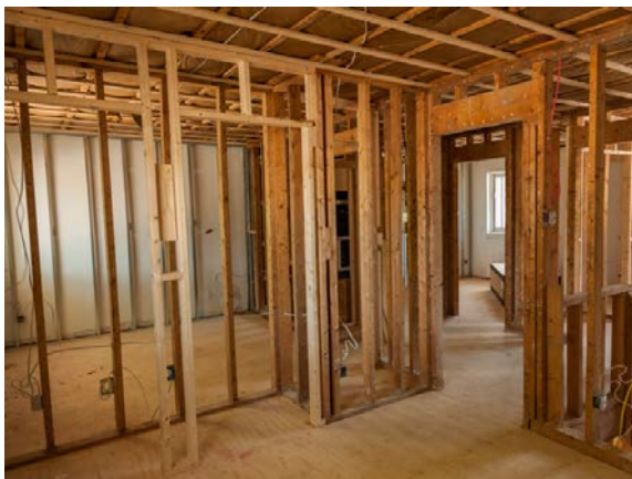
Un logement en travaux de modernisation
