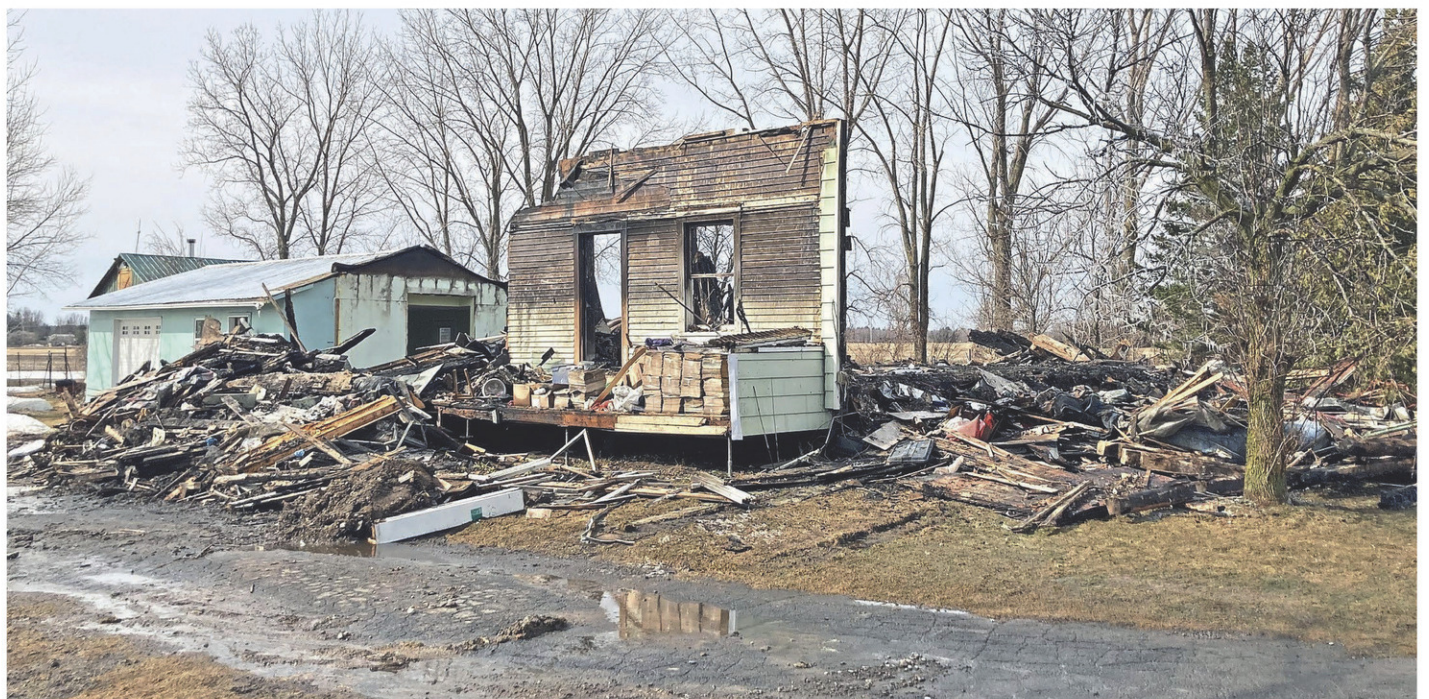
Un feu a complètement détruit une résidence située au 29, chemin de la Grande-Ligne, à Saint-Bernard-de-Lacolle, le 31 mars.
