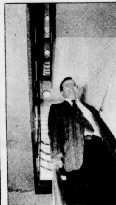
Les cages d'escaliers ouvertes sont une source de danger. S'il y avait un incendie, la fumée s'engouffrerait dans l'escalier, forçant l'évacuation de secteurs complets de l'hôpital.
