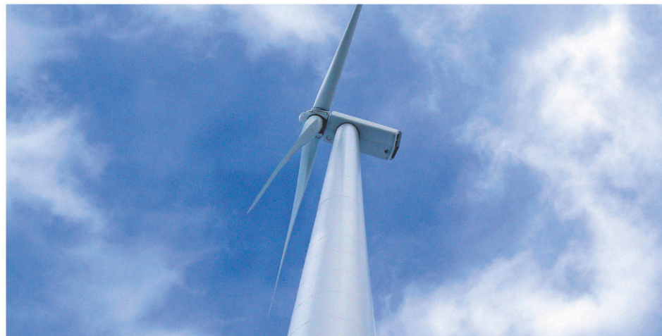
Le secteur où seront construites les six éoliennes. (Photo: Coup d'œil - Jacques Larochelle)
