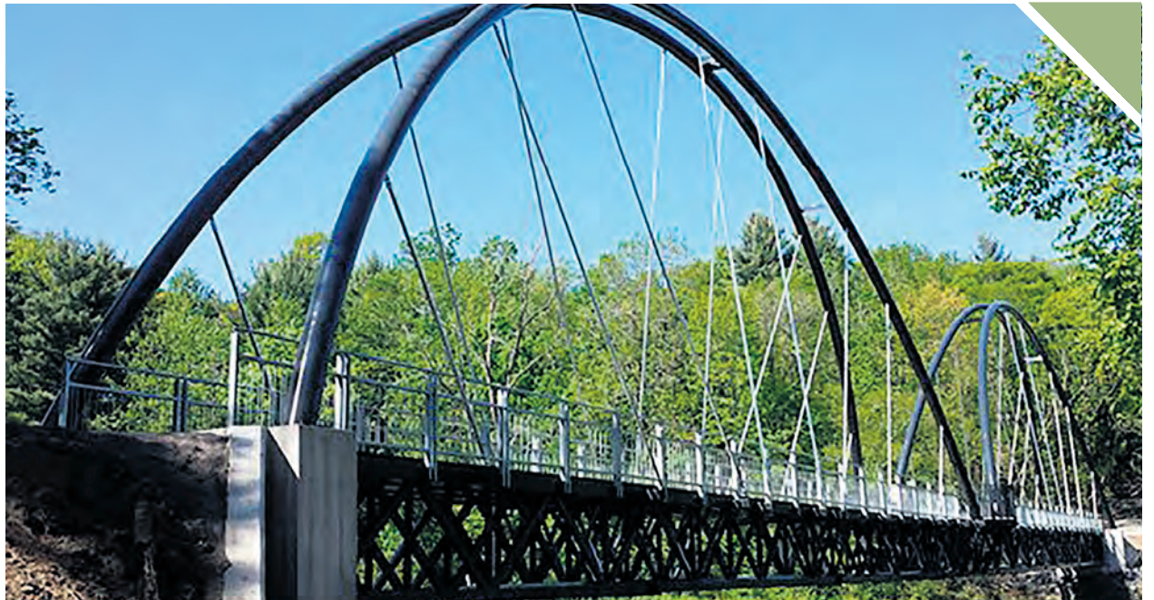
Pour prévenir les dégâts de possibles embâcles, la passerelle de l'Île Vessot sera rehaussée de cinq pieds. Photo - gracieuseté
