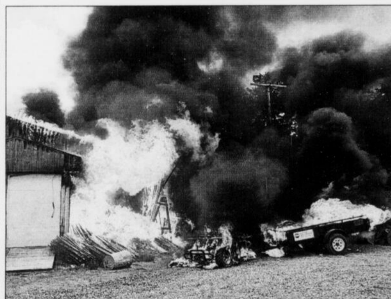
Le chalet d'accueil du parc Rivière-du-Moulin a été la proie des flammes, hier. Selon les premières constatations, le brasier aurait pris naissance sur un véhicule tout-terrain, stationné à l'arrière du bâtiment.
