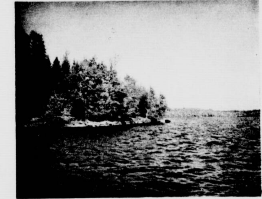
Le contrefort de l'île, où les Prud'homme ont construit le quai de pierres provenant de l'endroit même. L'exécution des travaux a pris deux longues années, et depuis, aucune des pierres n'a glissé malgré les degels de mars.
