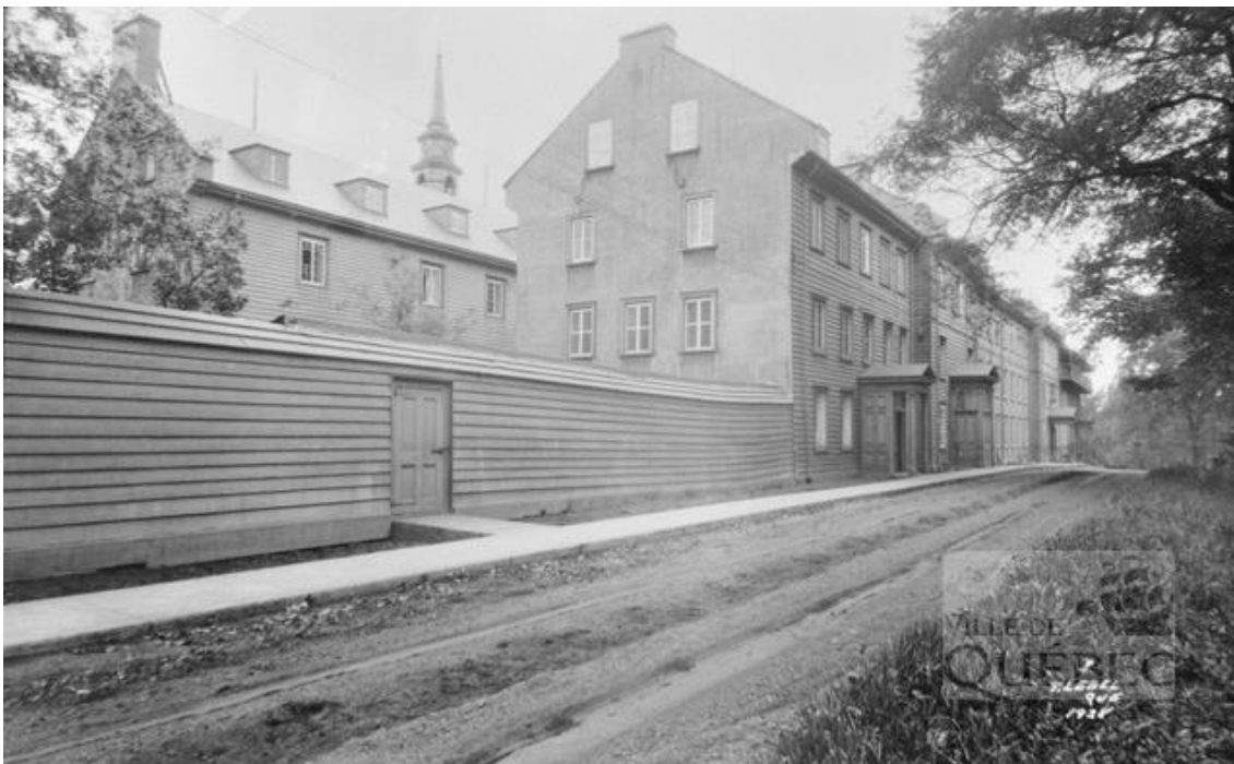
Figure 14 : Photographie de 1928, montrant le trottoir représenté par le vestige 27A100, avant sa démolition.
