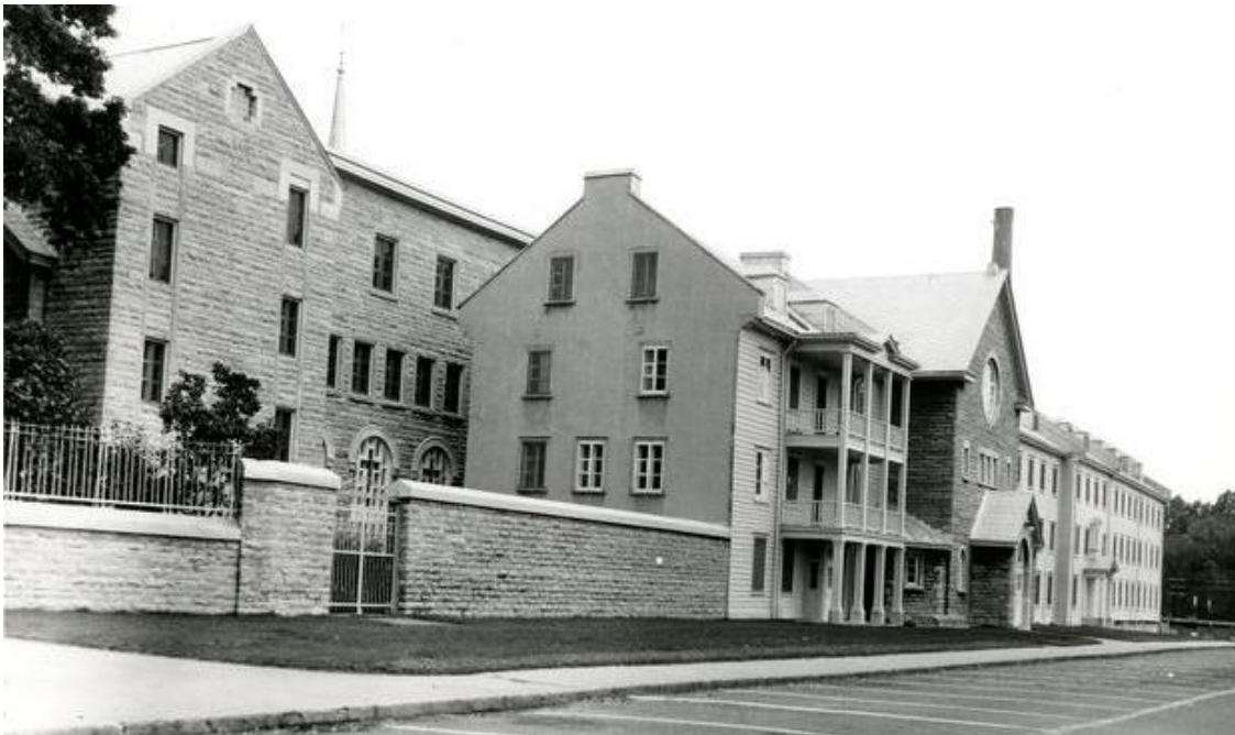
Figure 16 : Photographie de 1968 montrant les appartements de l'aumônier. En avant-plan, le nouveau trottoir, construit après l'agrandissement du vestibule de l'église en 1949.
