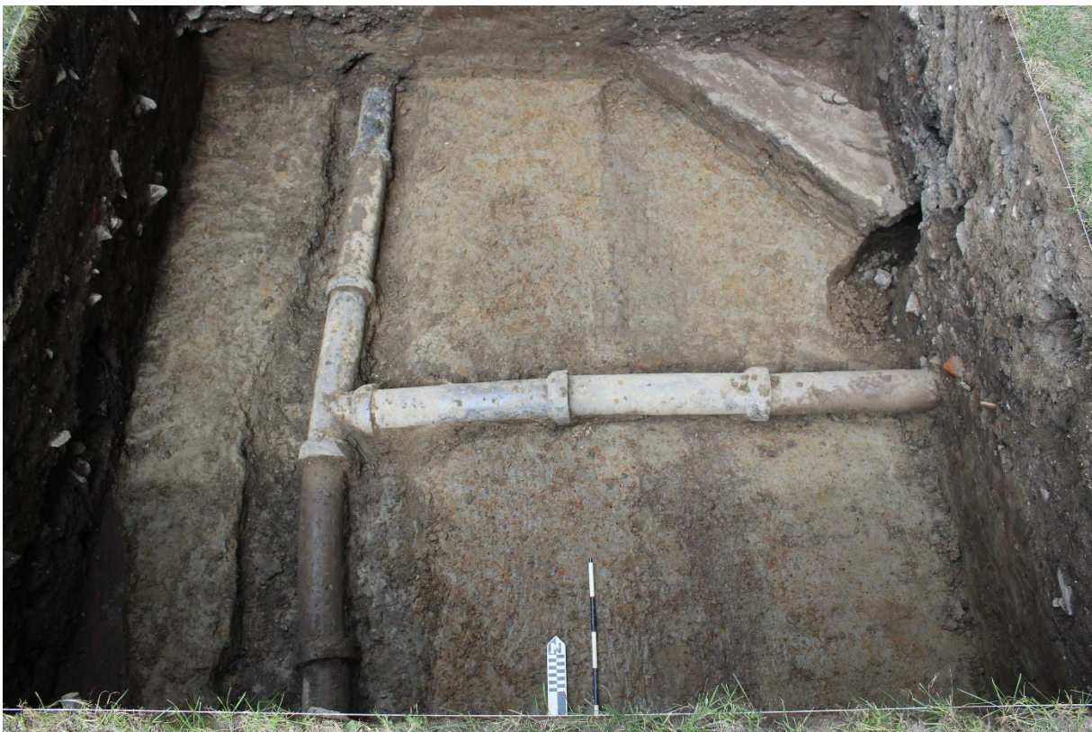
Figure 46 : Canalisation en grès (27C100) en forme de T, à la fin de la fouille (Photo : S. Noël).
