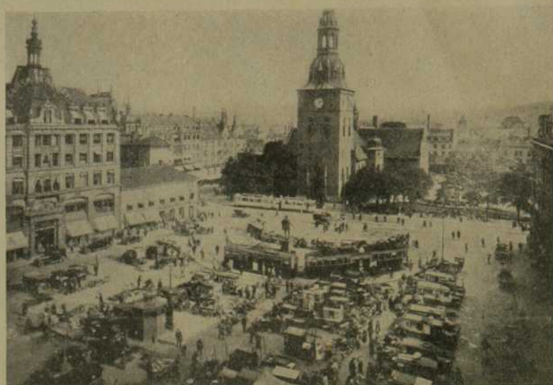
La place du marché, à Oslo, capitale de la Norvège. Bien que fondée en 1048, la ville d'Oslo fut si souvent ravagée par l'incendie, comme notre bonne ville de Montréal, que ses plus vieilles maisons, en très petit nombre, ne datent que du seizième siècle (ce qui est déjà joliment vieux !) L'église de Notre Seigneur, qui occupe le fond de la place, fut consacrée en 1697.
