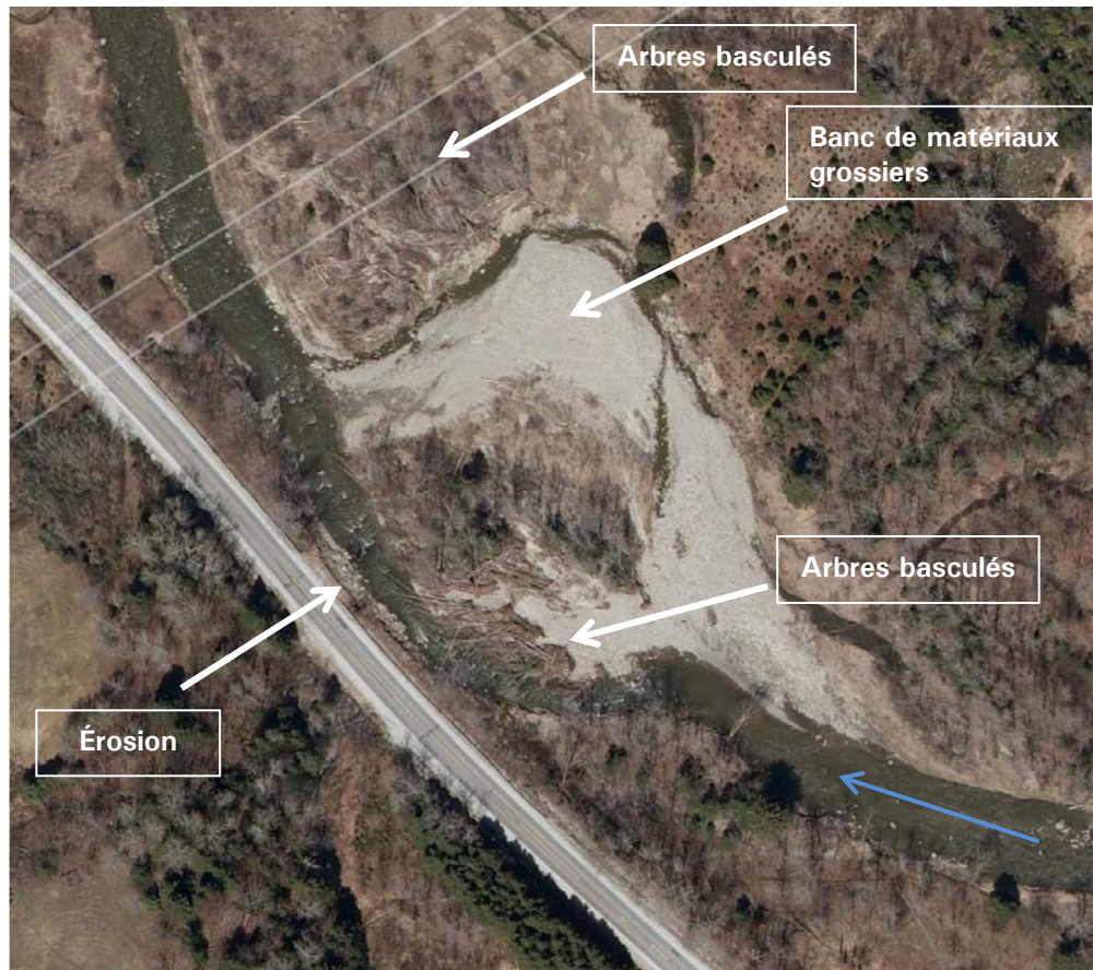
Photo 2 : Banc de matériaux grossiers au PK 46,4. Nombreux arbres basculés sur le lit de la rivière Bulstrode, par les glaces. On note de l'érosion à la base du talus bordant la route, sur la rive gauche. La flèche bleue indique le sens d'écoulement de l'eau.
