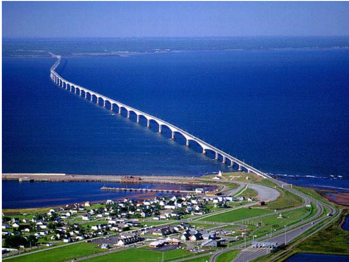
Pont de la Confédération
