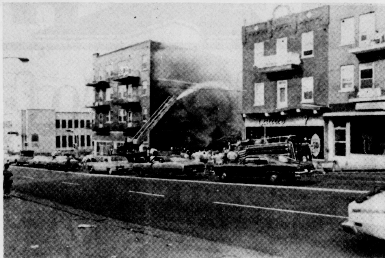
Vue prise sur l'avenue de la Station vers midi hier alors que les sapeurs-pompiers arrosaient toujours le vieil édifice de trois étages rasé au sol par les flammes et qui faillit créer une con-
