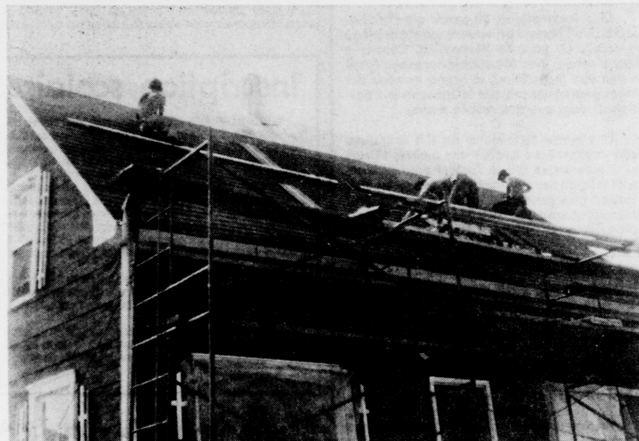
Beaucoup de besognes ont déjà été accomplies relativement à la reconstruction ou simplement à la réparation des maisons. (Photo Roland Lemire).
