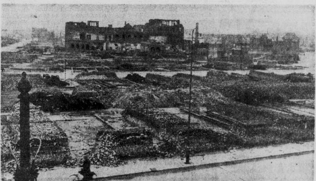
LA HOLLANDE ESSAIE D'OUBLIER : Voici une vue d'une zone bombardée à La Haye. On a fait le nettoyage des débris et sauvé la brique que l'on aperçoit en piles. Aucune tentative n'a encore été faite pour reconstruire les parties résidentielles. La rareté des matériaux et de la machinerie en est la cause. (Photo Central Press)
