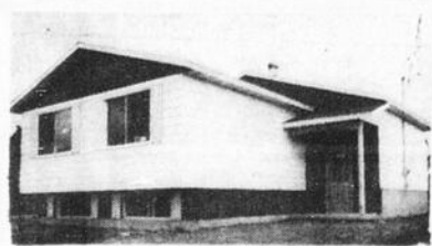
1645 AVE BOULANGER PLESSISVILLE
