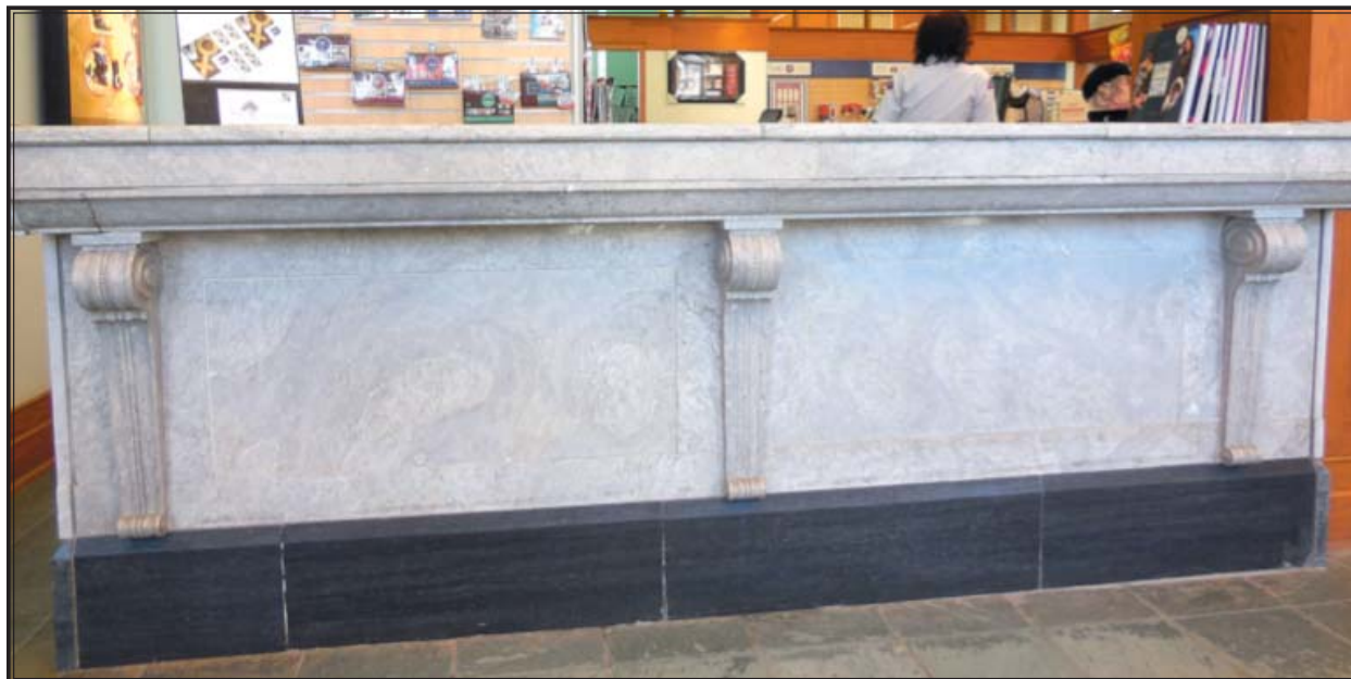
Le comptoir est formé de calcaire-marbre de Missisquoi; sur les deux panneaux apparaissent des structures sédimentaires arrondies appelées thrombolites . La plinthe est en calcaire-marbre noir de Missisquoi.
