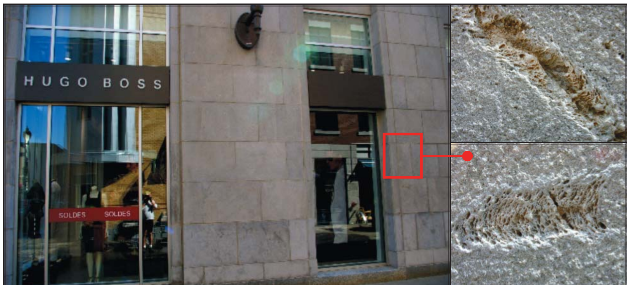
Rue du Parvis, parement en calcaire de Queenston et coraux du groupe des rugueux Rugosa . Mur rue du Parvis.
