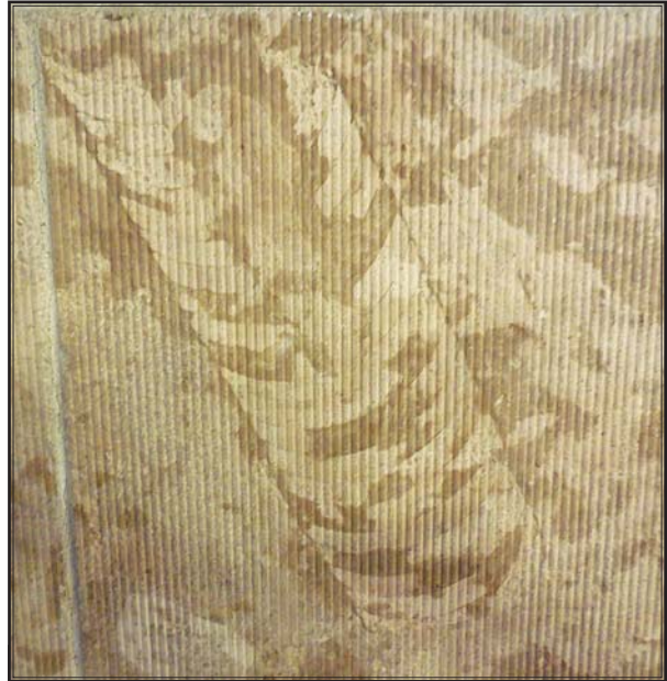
Céphalopode Orthoceras de 23 x 9 cm sur le mur gauche de la nef, sous la station V du chemin de croix. Les lignes verticales sont le fini peigné de la pierre.
