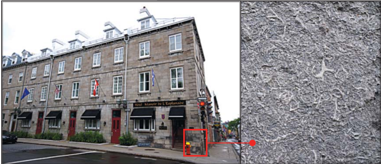
À gauche, le Manoir de l'Esplanade en calcaire de Pointe-aux-Trembles. À droite, bryozoaires Hallopora rameux dans le calcaire gris foncé de Pointe-aux-Trembles.
