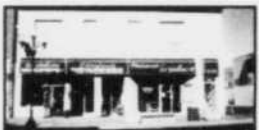
37. COWANSVILLE: Bâtisse commerciale avec théâtre en opération + 2 locaux commerciaux au centre-ville. ROLLAND CODERRE 293-2310
