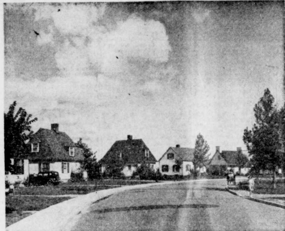
De coquettes maisons font d'Arvida une ville agréable. Pas de taudis, pas de quartier négligé. Partout les rues pavées, les trottoirs, les pelouses et de confortables maisons. Ce coin est bien typique de la ville de l'Aluminium, Arvida.
