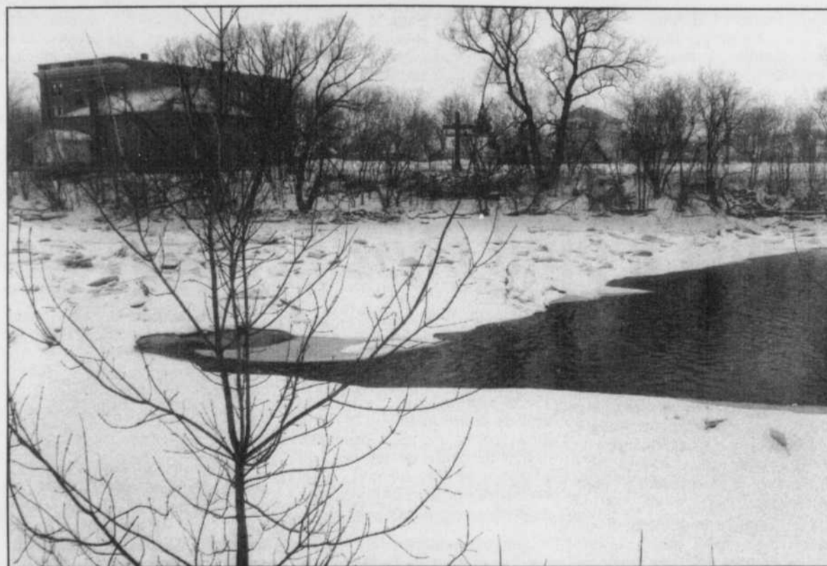
Un film d'huile flottait sur la rivière Yamaska la semaine dernière, conséquence d'un écoulement d'huile à l'usine de filtration de Farnham, indique le ministère de l'Environnement.
