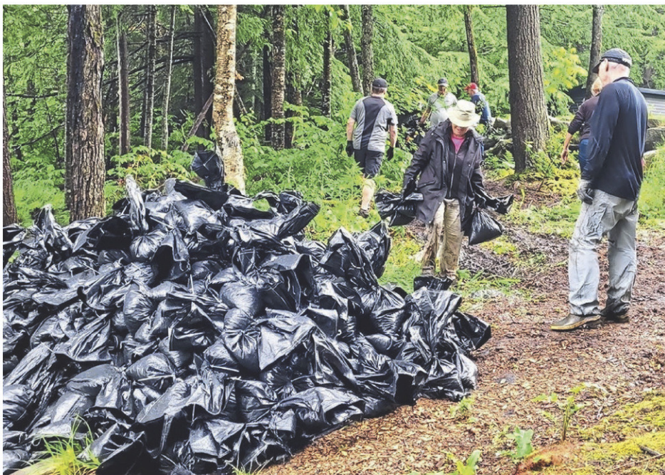
Plus de 1000 sacs de lestage ont été nécessaires pour l'installation des toiles de fond.
