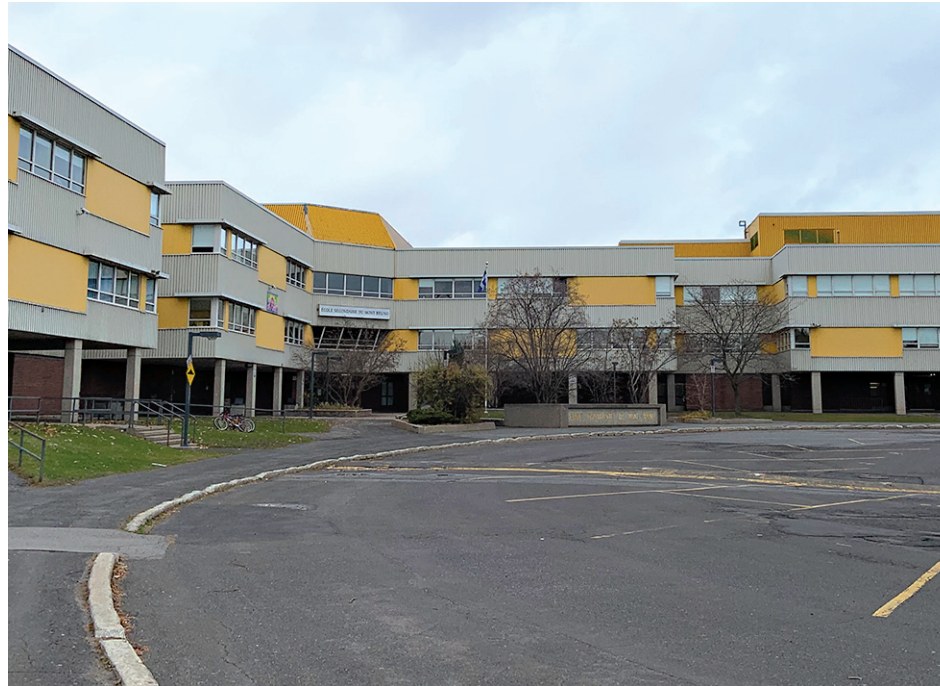
La piscine de l'école secondaire du Mont-Bruno étant fermée depuis le début juin pour rénovations, la Ville propose aux citoyens d'aller à ses piscines extérieures ou aux piscines de Boucherville et Sainte-Julie. (Photo : archives)
