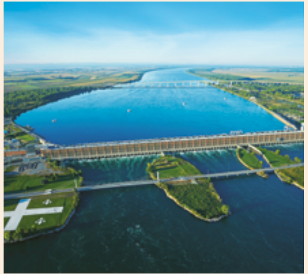
→ CENTRALE HYDROÉLECTRIQUE DE BEAUHARNOIS ©HYDRO-QUÉBEC
