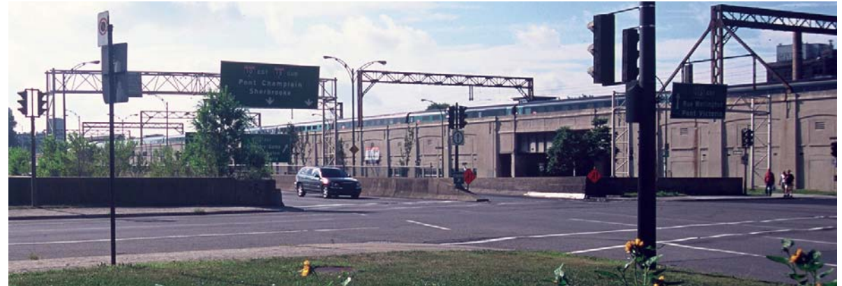
Vue actuelle du viaduc ferroviaire, au niveau de la rue Notre-Dame.
