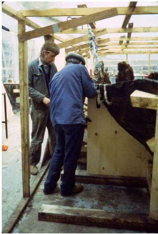
Figures 32 et 33 : Des supports conformés aux parois de l'embarcation ont été installés pour soutenir la forme retrouvée. À cette étape du traitement, le bois, qui a subi un séchage progressif accompagné d'imprégnations répétées de polyéthylène glycol, est maintenant presque sec. Photographies : CCQ
