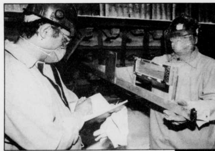
Après cela, Claude et Émile retournent dans l'Usine afin d'effectuer une évaluation à l'aide de l'angle de plantage. Cet outil permet de vérifier si la cuisson des anodes est normale.
