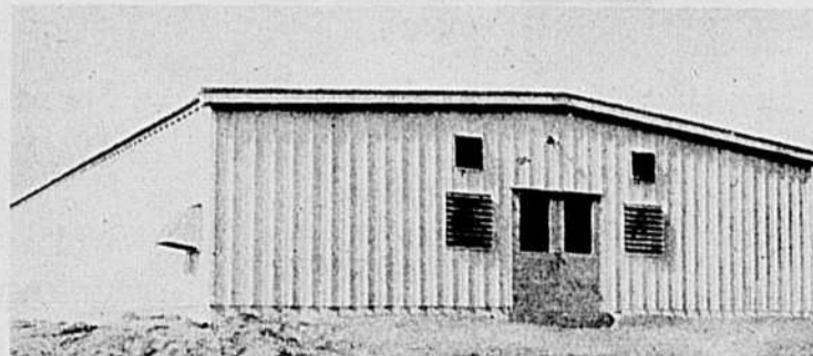
BÂTIMENT D'ACIER BUTLER
