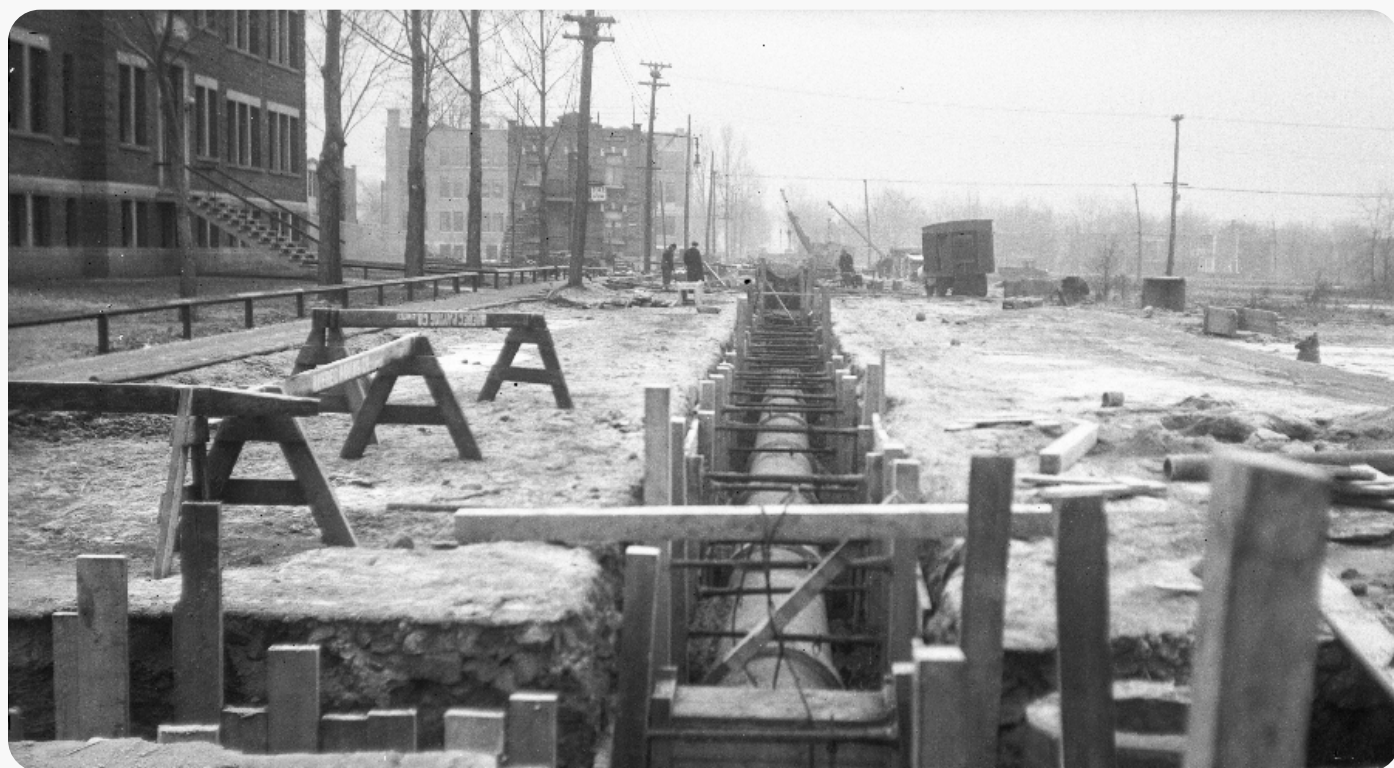
Travaux d'égout sur la rue Prieur Est en 1933. À gauche, l'école Ste-Marthe.
