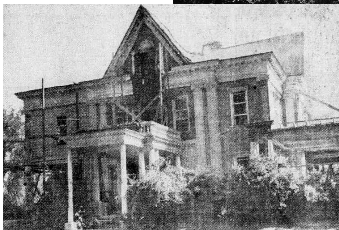
Elmwood Residence, le lendemain de l'incendie. La Presse, 14 juillet 1942, page 3. BAnQ Numérique
