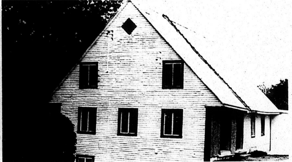
Le moulin des Ursulines, aujourd'hui devenu le moulin Saint-Louis, est situé au 1331 rang de la Petite Carrière, le plus vieux rang de Sainte-Ursule. Les proprié-
