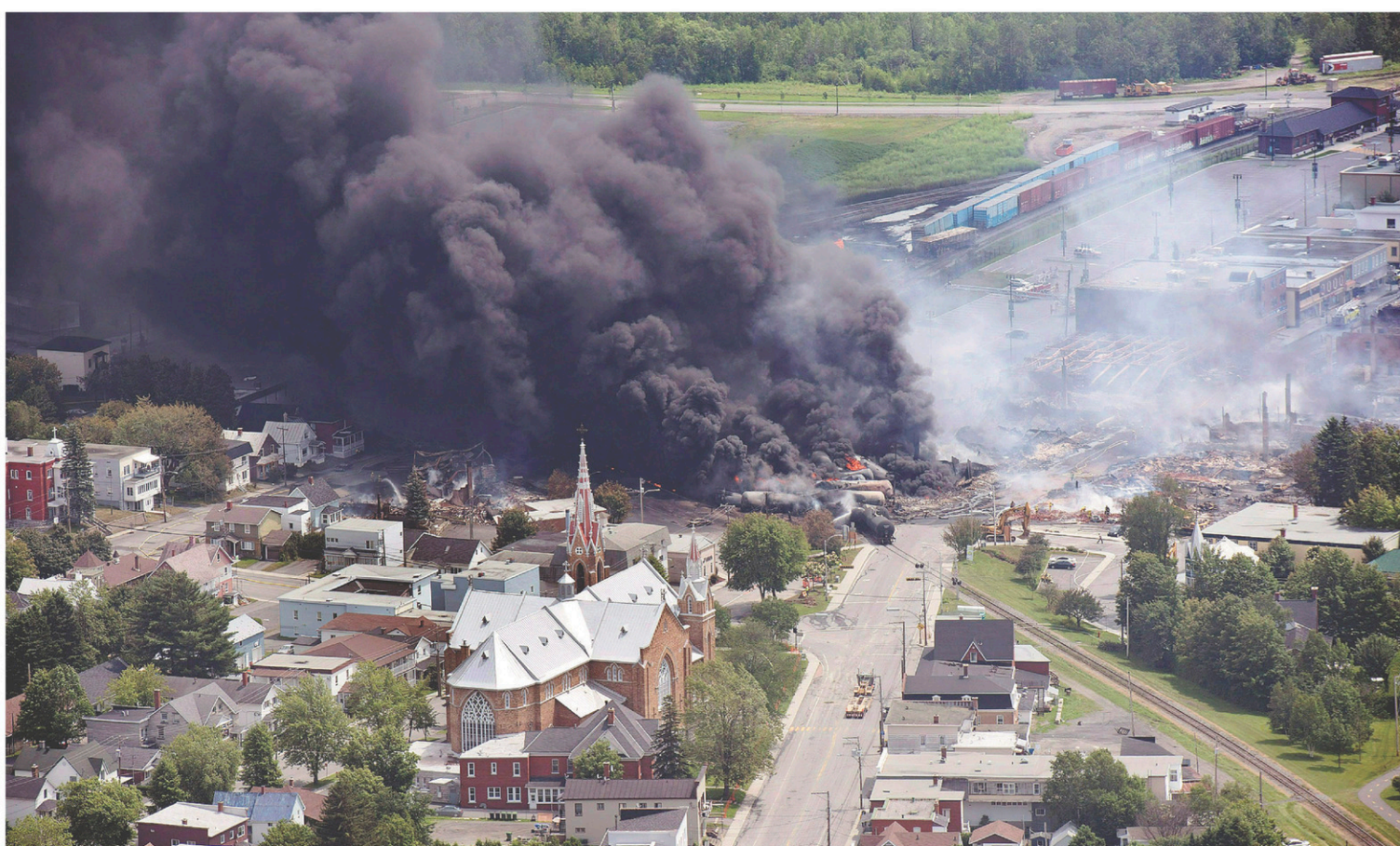
Quarante-sept personnes avaient perdu la vie en juillet 2013 lorsqu'un train de 72 wagons-citernes avait explosé en plein cœur de Lac-Mégantic. Depuis, la Ville réclame que la voie ferrée soit déplacée loin du centre-ville.
