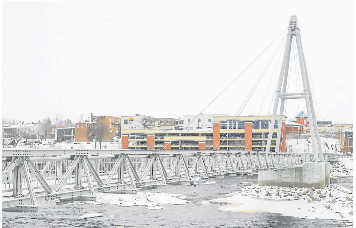
La passerelle piétonnière aménagée au-dessus de la Petite Décharge, au centre-ville Alma, a nécessité le développement d'une expertise importante en matière de soudage par friction-malaxage. — PHOTO LE QUOTIDIEN, GIMMY DESBIENS
