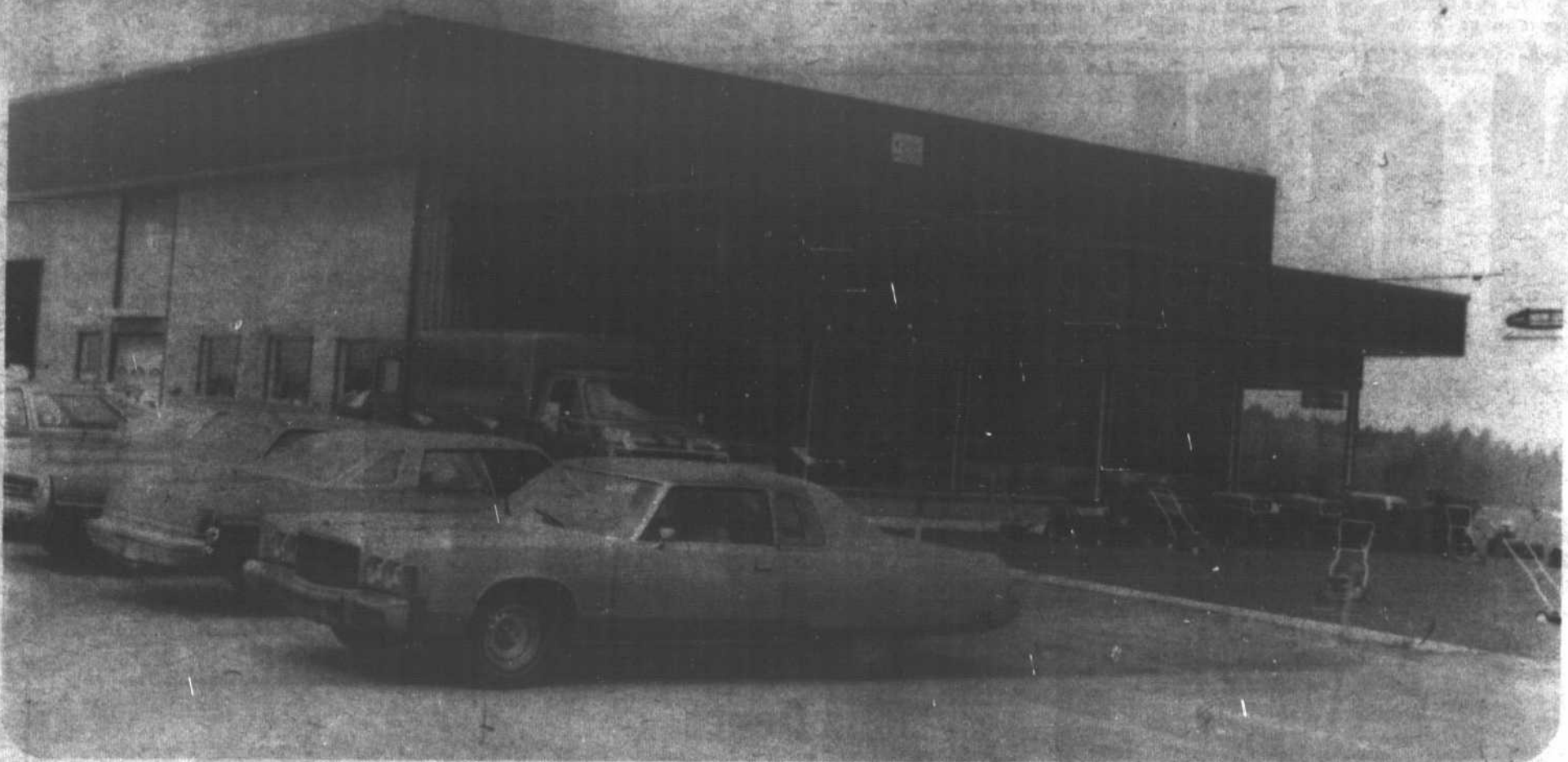
Le garage de la coopérative, construction nouvellement terminée.
