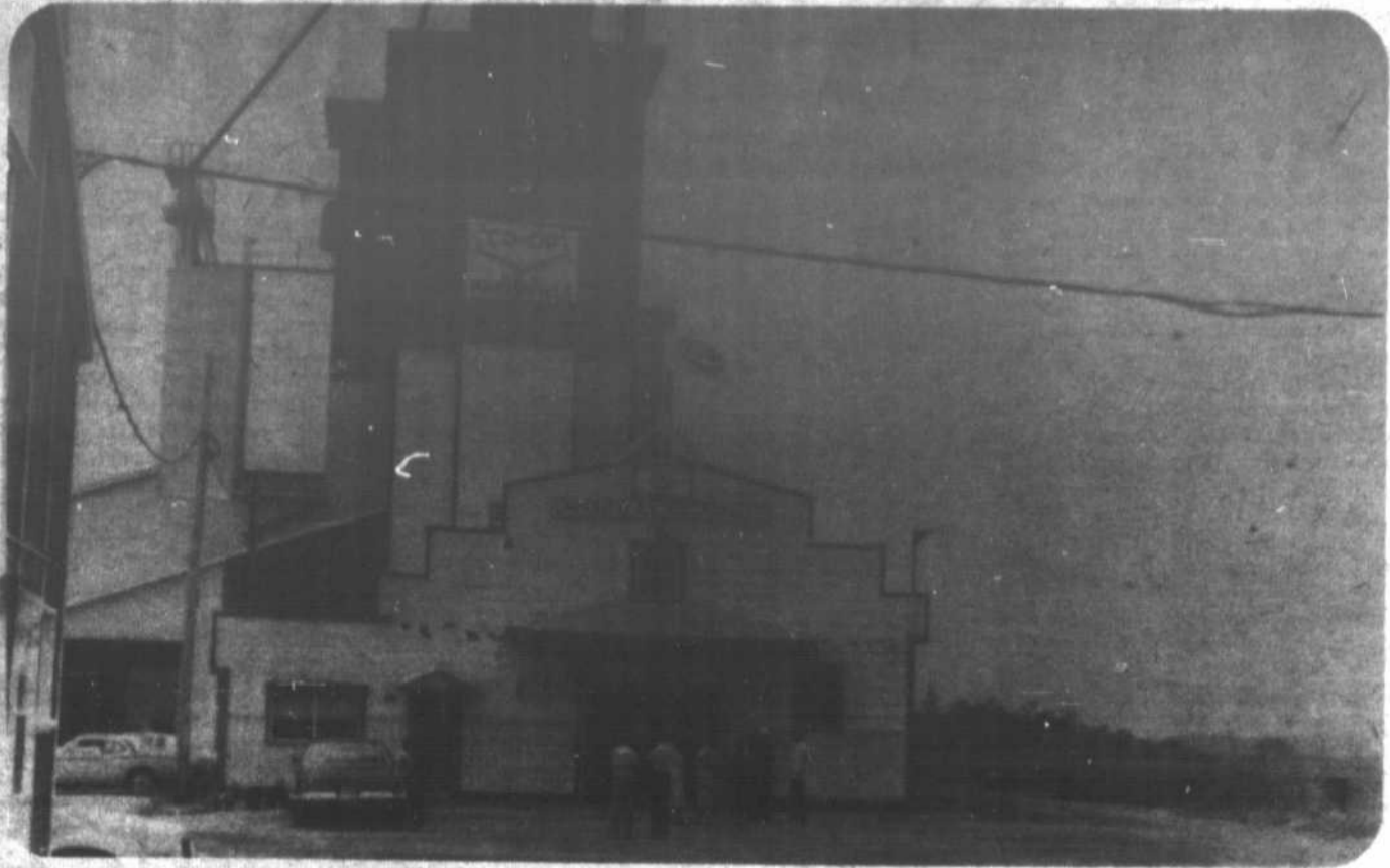
La meunerie de la Coopérative de Parisville a été rénovée en 1978.
