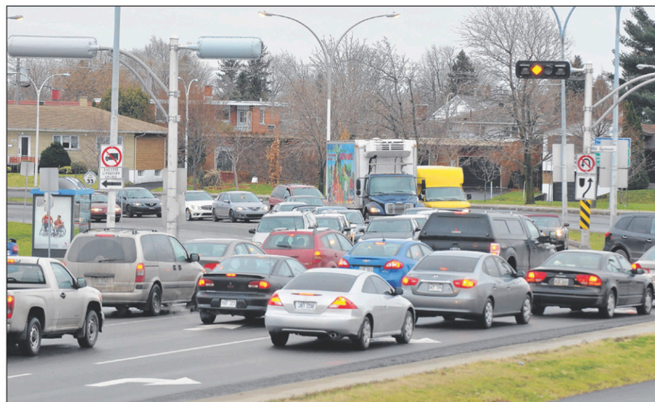
La zone de chantier couvre le carrefour de Séminaire et des entrées et sorties de la 35.
