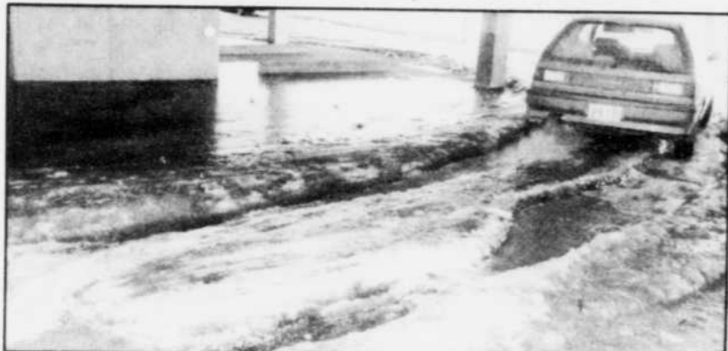
Toujours dans un état lamentable, le stationnement étagé du complexe La Promenade, au centre-ville de Shawinigan, est recouvert d'une épaisse couche de glace et embête bien des automobilistes qui s'y aventurent.
