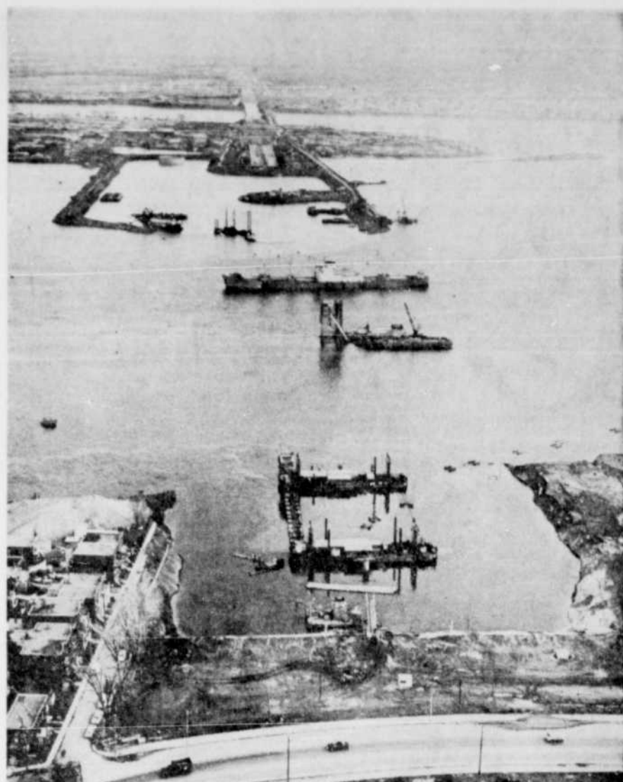
L'ENSEMBLE DU CHANTIER DU PONT-TUNNEL LOUIS-HIPPOLYTE-LAFONTAINE VU DU COTE NORD. — On remarquera, au centre du fleuve, de ce côté-ci du navire, l'appareil d'injection de sable. Ce pont, auquel est accroché un chaland, roule sur le toit de l'élément submergé. A sa droite est accroché à la verticale un tuyau par lequel est poussé le sable qui remplira l'espace de 4 pieds entre le fond de la tranchée et le plancher de l'élément. C'est sur cette couche de sable que sera assis définitivement chaque élément.
