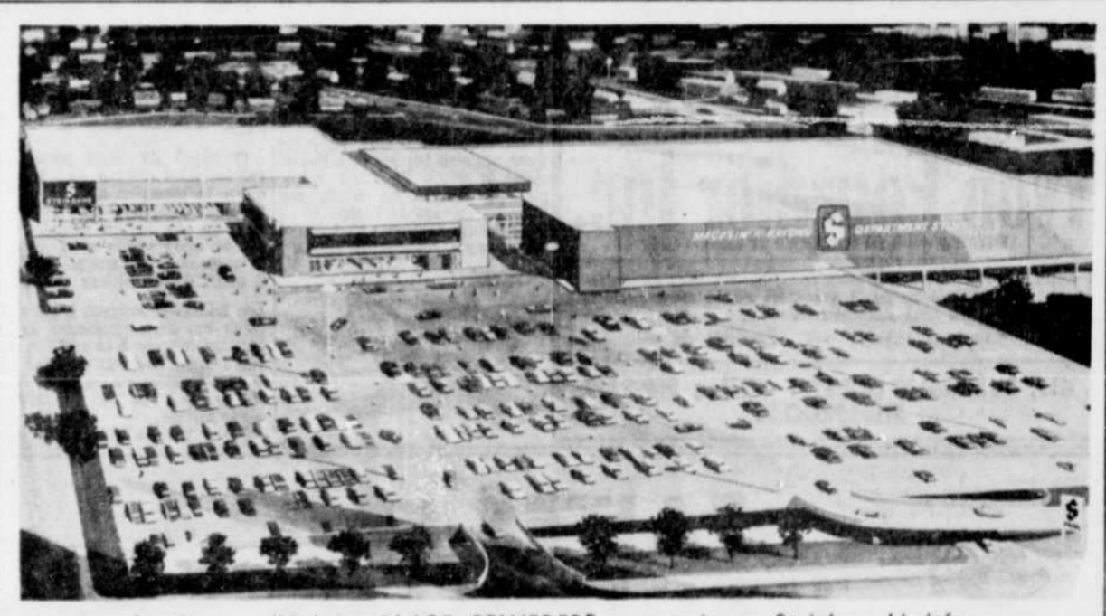
Le Centre d'Achats, PLACE BELVEDERE, construit par Steinberg Limitée.
