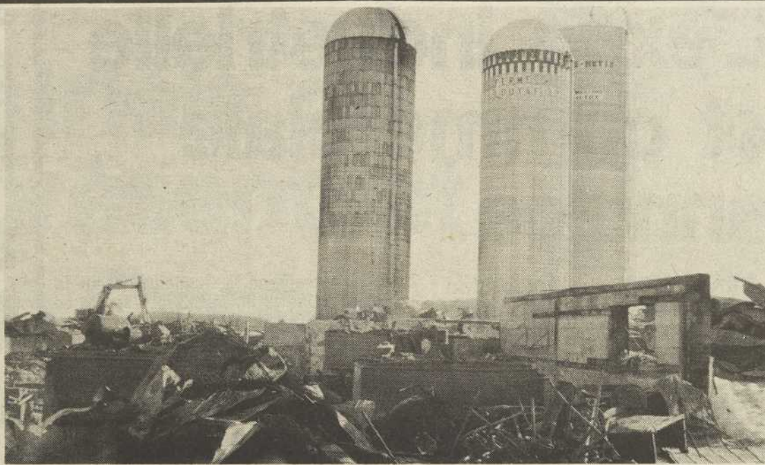
Des amoncellements de tôle jonchent le sol. Il faudra quelques jours de nettoyage avant qu'on procède au nivelage du terrain.
