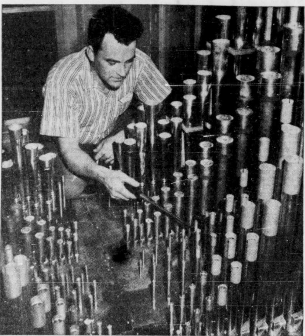
IL Y EN A 1800 — On procède présentement à l'ajustement des tuyaux de l'orgue que la Société Pratt est en train d'installer à la chapelle du petit séminaire de Chicoutimi. On voit, ici, M. Laureat Lapointe, de Montréal, qui effectue ce travail d'artiste. Il y a 1800 tuyaux allant de 3 pouces à 16 pieds.
