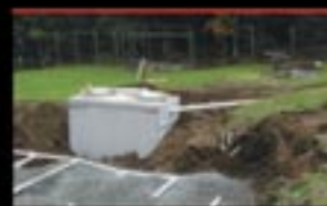
INSTALLATION DE FOSSE SEPTIQUE
