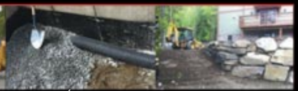
RÉPARATION DE DRAIN FRANÇAIS
