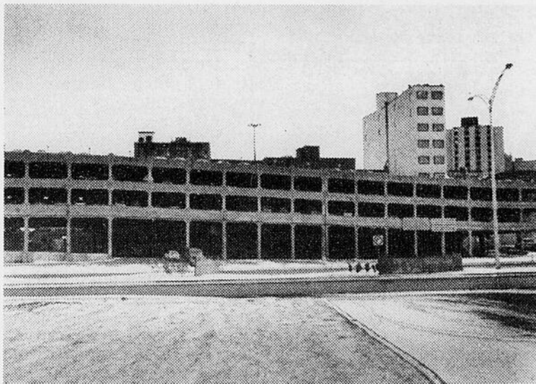
AUTO - L'autogare Place Racine, construit en 1967, ne répond plus aux critères de sécurité et la ville a décidé de le fermer tout simplement aux automobiles. (Photo Sylvain Dufour)
