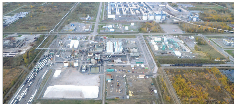
L'usine d'engrais d'IFFCO sera érigée au parc industriel et portuaire de Bécancour, sur un terrain situé dans le coin supérieur droit sur cette photo aérienne. PHOTO NICOLAS DUCHARME
